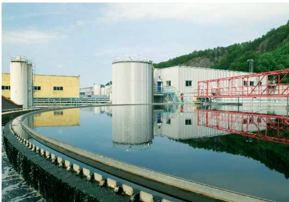
Fra renseanlegget ved Norske Skog Saugbrugs.
